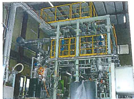
藤井基礎設計事務所と清水建設などが共同で建設した隠岐の島のバイオプラ研究施設
