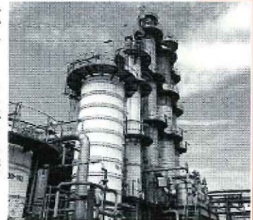
広大な敷地で機械が整然と稼働している
