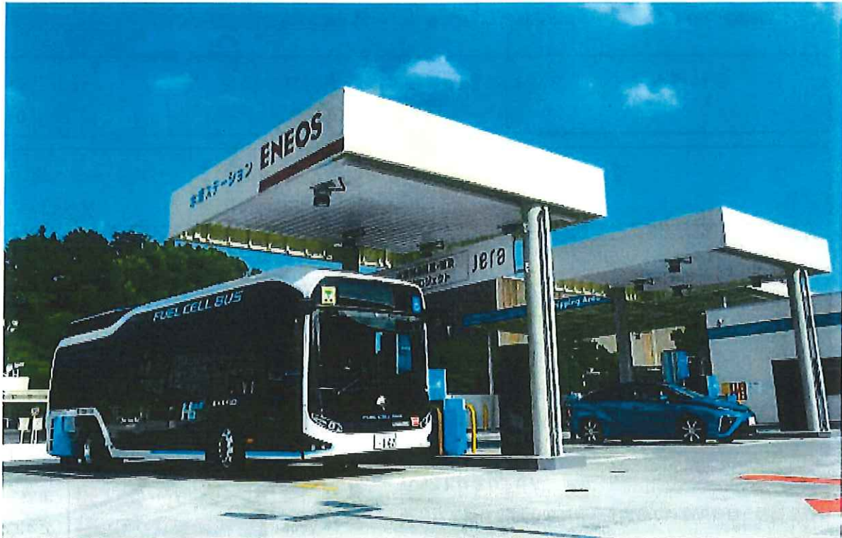
ENEOSとJERAが共同で開設した「東京大井水素ステーション」（東京都品川区）
