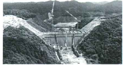
大林組は三重県伊賀市で川上ダムを施工している
