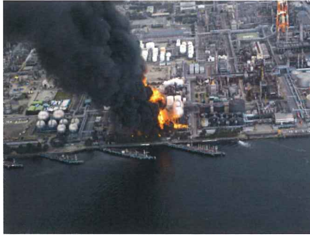
東日本大震災では各地の製油所が機能停止に陥った（2011年3月11日、千葉県市原市）
