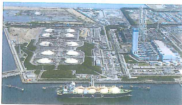
日本の発電量の3分の1を占めるJERAも2050年に温暖化ガス排出の実質ゼロを目標に掲げた（写真は千葉県富津市のJERAの火力発電所）
