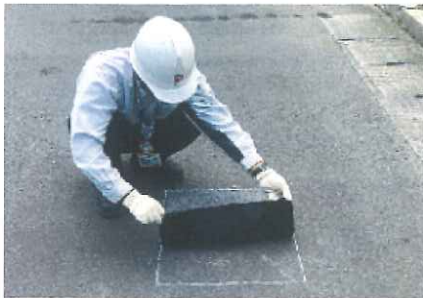
補修作業の様子
