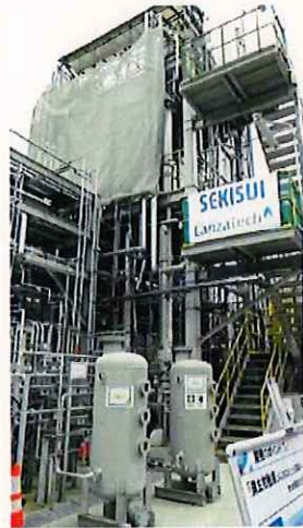
エタノールを積むパイロットプラント
