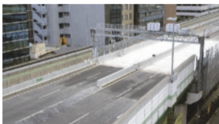
U F C床版でリニューアルした阪神高速 1 2号守口線本線
