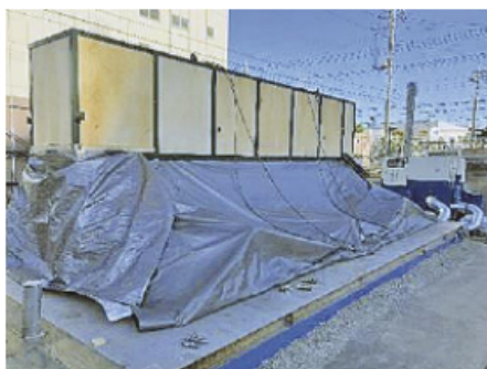
PCa部材の蒸気養生
