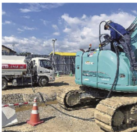
GTL 燃料給油作業
