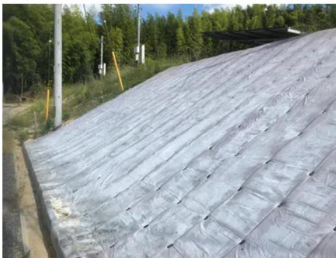
中村建設が自社の裏山に試験施工したドライマット（山口県宇部市）
