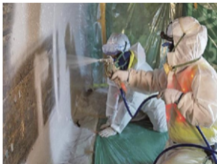
ワンバインドスプレー吹き付け（報道発表資料から）
