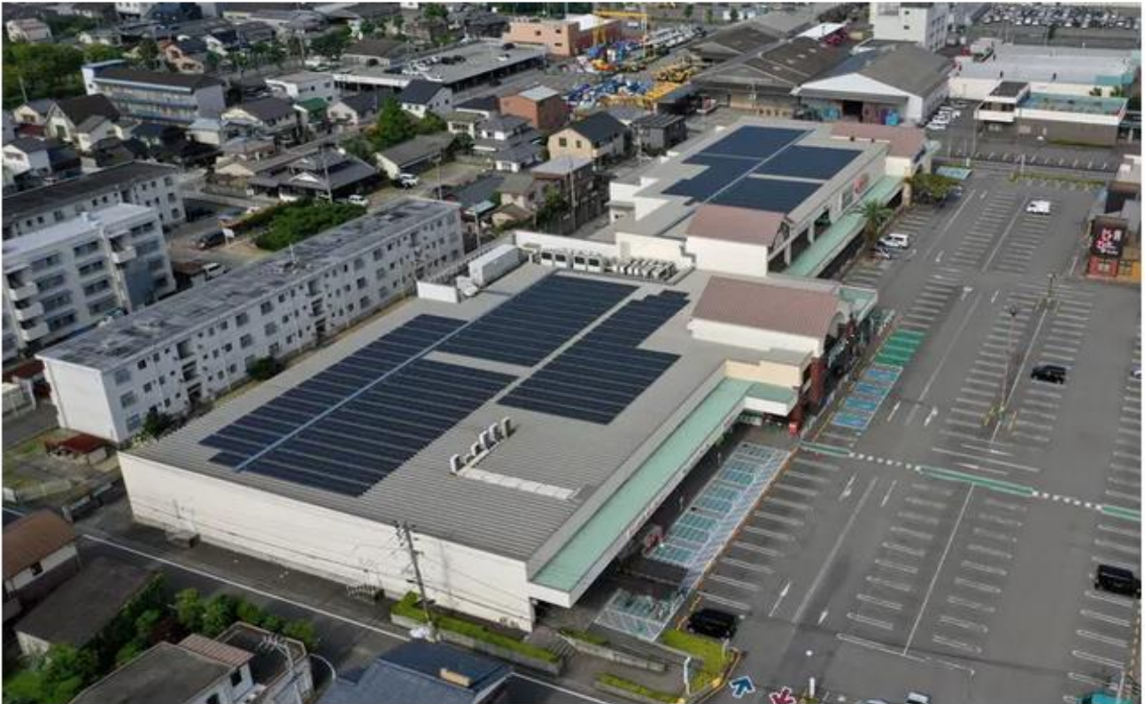
アイ・グリッド・ソリューションズの子会社VPPジャパンが設置した屋根置き型太陽光発電システム
