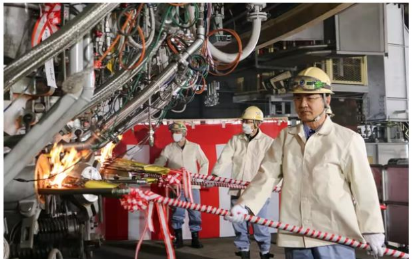
西日本製鉄所倉敷地区の「第4高炉」は13日に再稼働した（火入れの様子）
