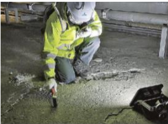
ダクト内の様子
