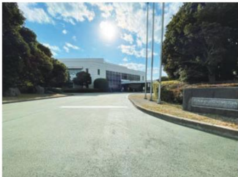
CO 2 を固定したアスファルト舗装
