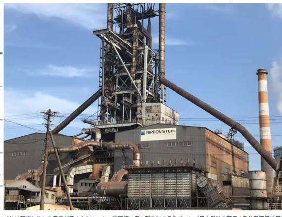
「鉄は国家なり」の言葉が示すように、かつて高炉は日本製業の象徴だった（日本製鉄の東日本製鉄所鹿島地区）
