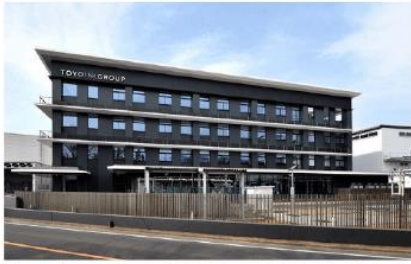
トヨケム ・川越製造所の技術管理棟
