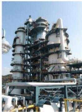
木質バイオマスの分解油化によるバイオ原油の製造で活用を検討するRFCC装置（四国事業所）
