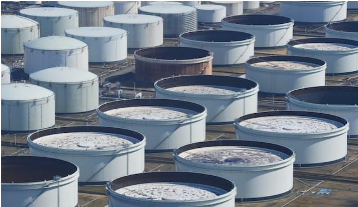
原油や石油製品などの貯蔵タンク
