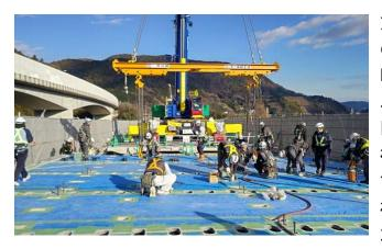
熊谷組は高速道路の橋桁上部の床版を更新する作業にかかる時間を従来の半分に短縮できる工法を開発したと発表した。床版同士をつなぐ金具を改良し、様々な橋の床版取り換えに対応できるようにした。高速道路の老朽化が進むなか、現場の制約が大きい都市部などの更新に使い
