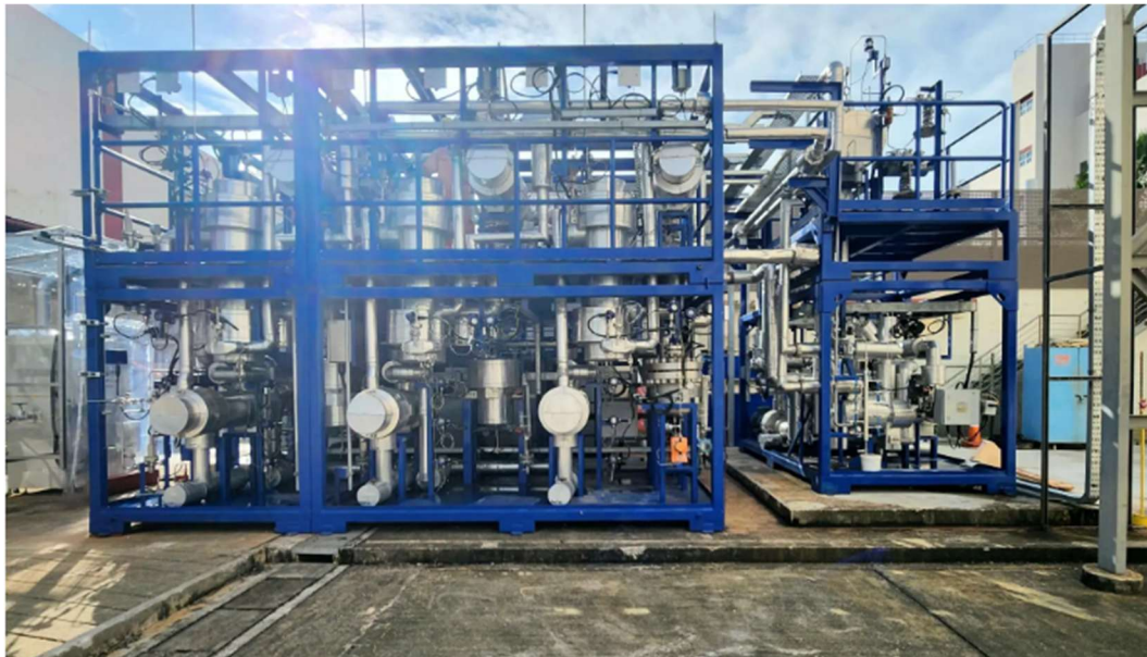
【写真: 小型スケールの SAF 製造試験装置】
