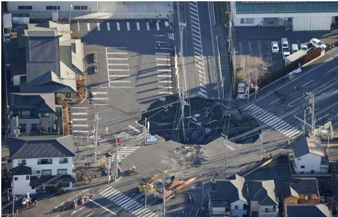
【写真：埼玉県八潮市の道路陥没現場（30 日午前 7 時 53 分）=共同】
