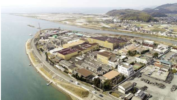
【写真：半導体製造装置に使われる塩化ビニール樹脂の材料を製造するタキロンシーアイの工場（兵庫県たつの市）】
