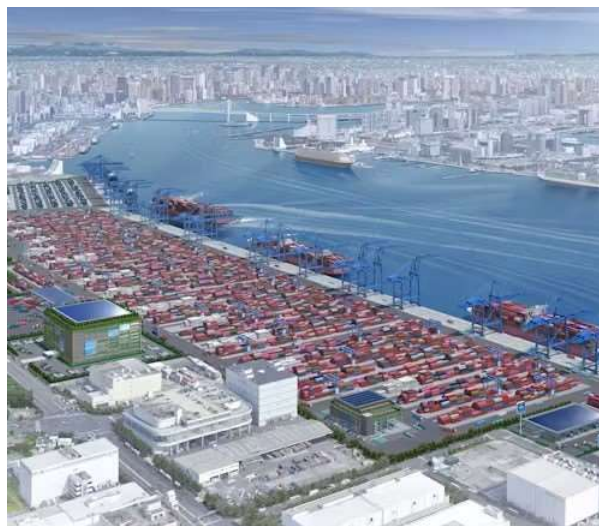
主力ふ頭である大井コンテナふ頭の拡張後のイメージ=東京都港湾局提供
