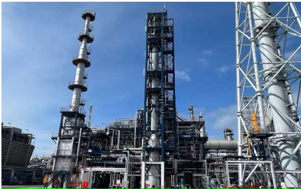
完工した SAF 製造装置(6 日、堺市)
