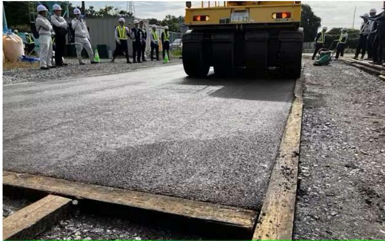
日本製紙と東亜道路工業が開発した「アスファルト混合物用乳剤」は常温での施工を可能にする
