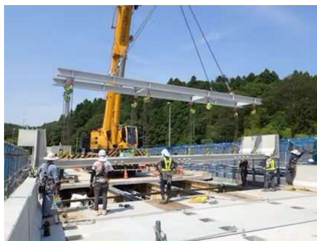
橋梁事業では補修の売り上げ構成比が急速に高まると見込まれる（日本ピーエスの作業現場）
