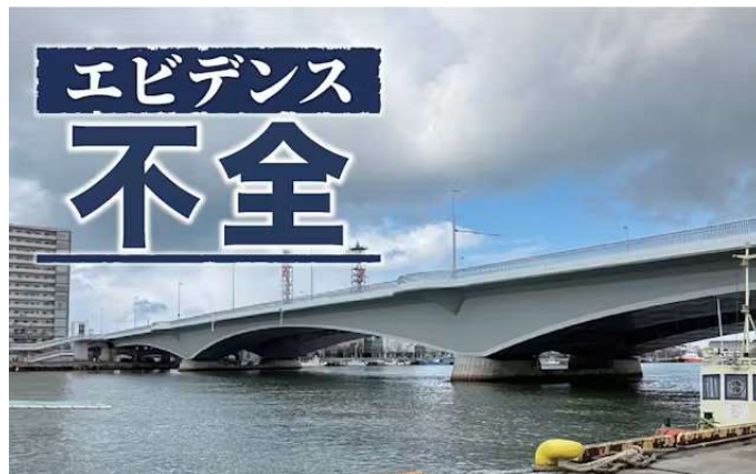
交通量が計画の4割にとどまる万代橋下流橋(新潟市)
