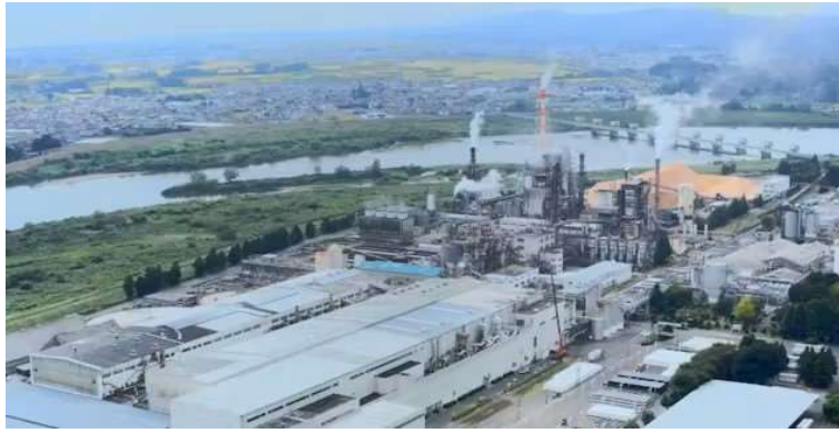
バイオエタノールの生産設備をつくる日本製紙の岩沼工場
