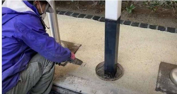
日本乾溜工業の「かぐやロード」は、酸化マグネシウムと水の化学反応で硬化する(同社提供)
