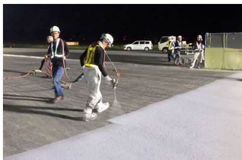
滑走路の誘導路を舗装する作業員＝7日未明、成田空港(NAA 提供)
