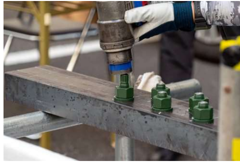
強度を高める高力ボルト(写真:大上 祐史)
