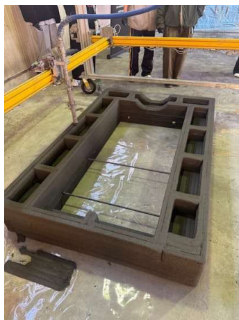
3D プリンターはノズルから出るモルタルで成型する(ホクエツの工場、石川県かほく市)
