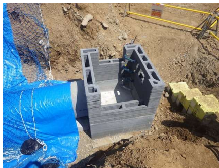
能越道穴水 IC 付近の工事で使った 3D プリンター製の集水枡(国土交通省提供)
