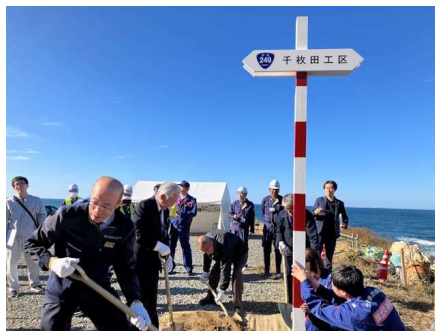
中心杭を設置する作業には輪島市の坂口茂市長⑤も加わった
