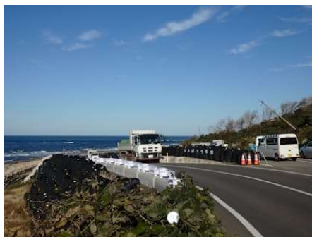
白米千枚田付近では隆起した海岸の上に仮設道路を設けた
