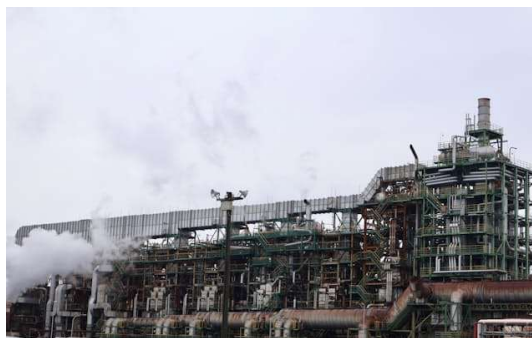
東ソーの四日市事業所のエチレン生産設備(三重県四日市市)
