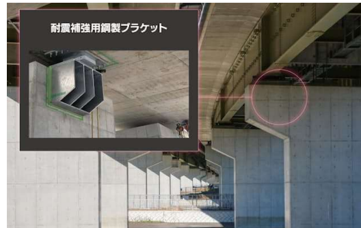
橋梁耐震補強用鋼製ブラケット=人機一体提供
